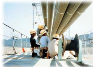
本四架橋工事落下防止調査
