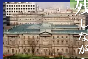
「日本銀行本店」/1896年 (明治29年)竣工 (1974年:重要文化財に認定)
